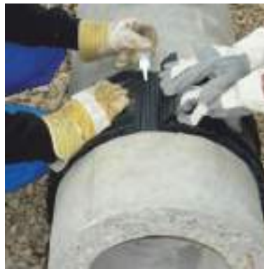
Giunti di riparazione aperti multidiametro OPEN
