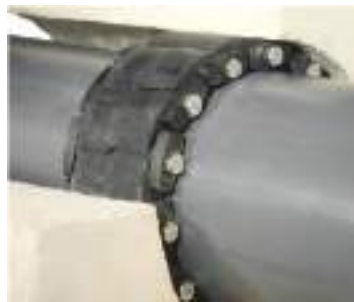
Giunto passamuro Wall bushing
