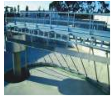
Ponti raschifango a trazione periferica
