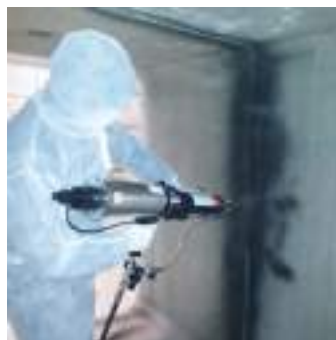
Rivestimento e protezione vasche e canali
