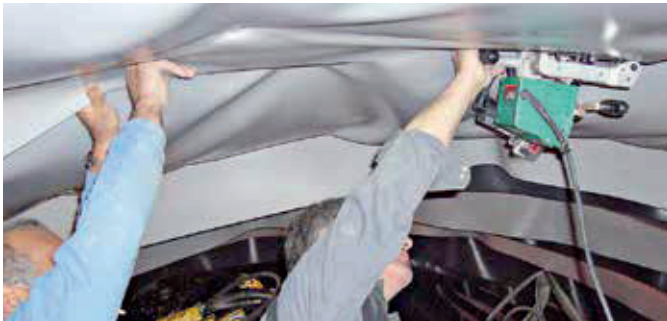
Applicazioni di COMET nei tunnel...
