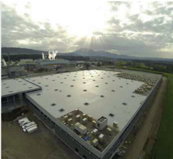
Aldi centro logistico 50000m2 TPO membrana, Svizzera
