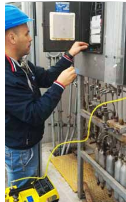
Verifica catene di misura gas
