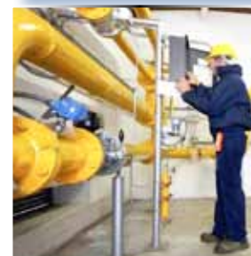
Attività di manutenzione presso impianto RE.MI.
