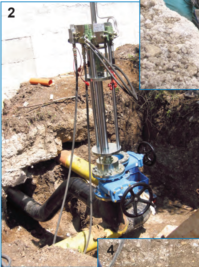
Foto 2 Macchina foratubi idraulica Hydraulic pipe drilling machine
