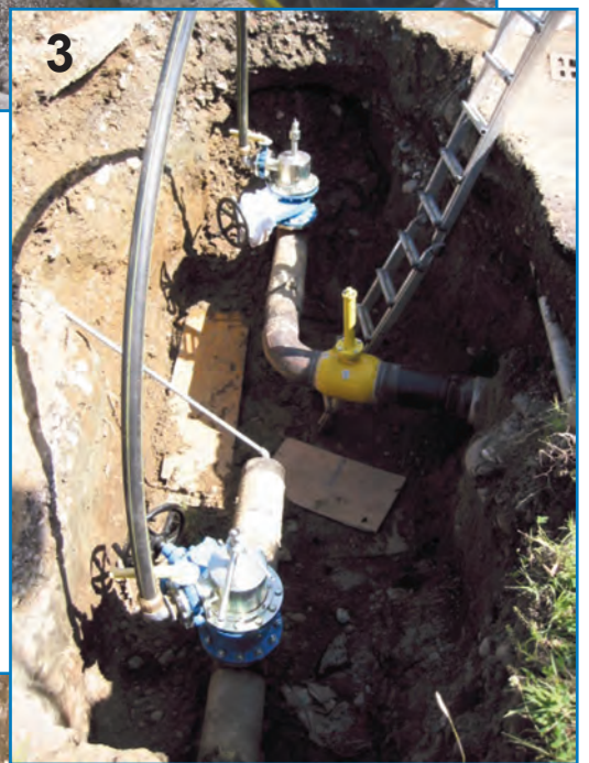
Foto 3 Tamponatrici DN 8" Plugging machine DN 8"
