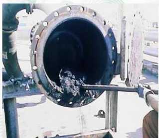
RIMOZIONE DEI SEDIMENTI PARAFFINOSI E DEL PRODOTTO DI CORROSIONE DOPO IL PASSAGGIO DI PIG DI PULIZIA
