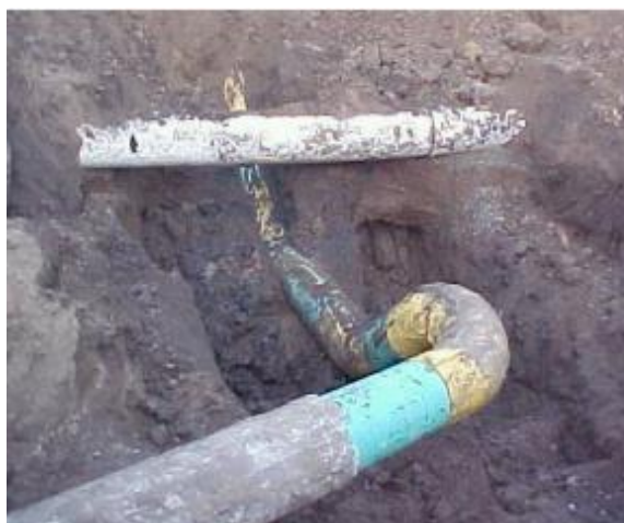
Serie di curve e controcurve aventi raggio pari a 1,5D non conosciute.
