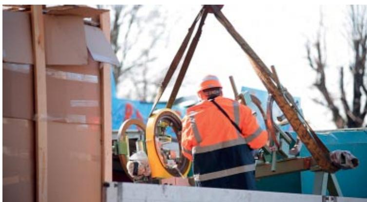
Per l'esecuzione del lavoro i tecnici delle aziende di gestione, in collaborazione con la funzione tecnica di In.Te.Co., hanno predisposto due scavi, uno per ogni estremità del Ponte Coperto, nei quali sono stati intercettati le due condotte da risanare.
