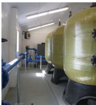
Bayoxide, mezzo filtrante per la rimozione dell'arsenico
