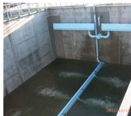
Severn Trent Services Jet Aeration Processo a fanghi attivi ad aerazione forzata
