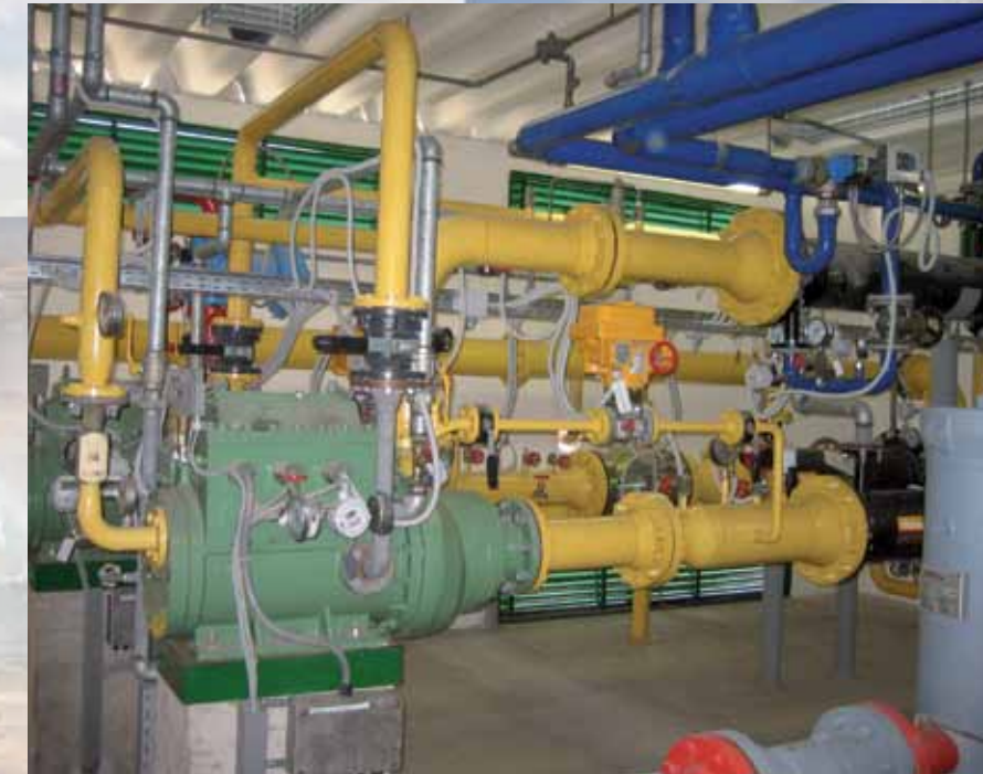
Il primo turboespansore abbinato a cogenerazione da fonte rinnovabile
