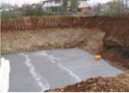
Preparazione e compattazione del fondo Preparing and compacting the bed
