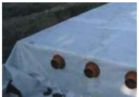
Rivestimento vasca con membrana impermeabile e tessuto di protezione / Complete cladding of the tank with impermeable membrane and protective sheeting
