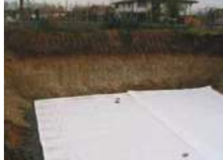
Stesura del tessuto di protezione e rivestimento Laying the protective / cladding sheet
