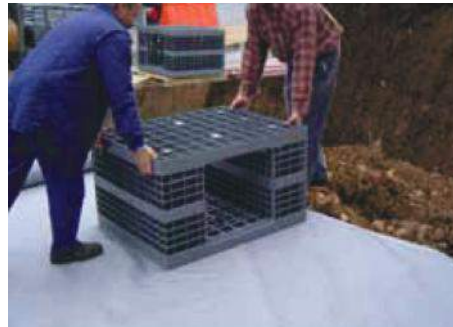
Movimentazione manuale di allineamento celle Manually aligning the cells
