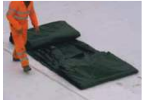
Posizionamento della membrana impermeabile Placing the impermeable cladding membrane
