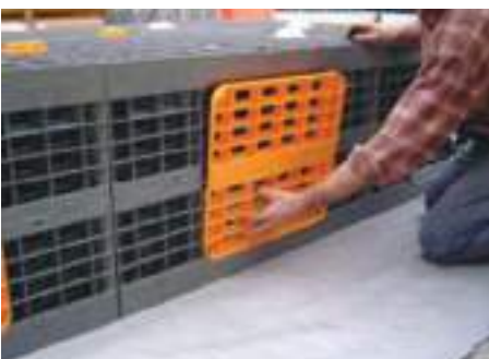
Posizionamento tappi di chiusura perimetrali Manually fitting the perimeter caps
