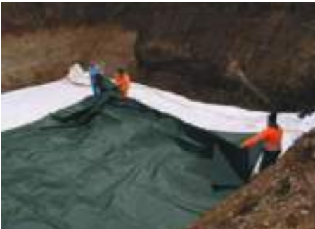
Stesura della membrana impermeabile Laying the impermeable cladding membrane
