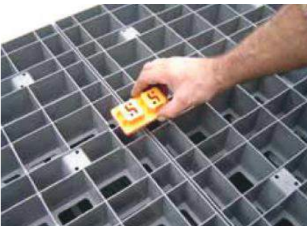
Posizionamento delle clip/perno al centro cella Positioning the clips/central internal column
