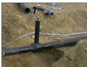
Collaudo allacciamenti gas in bassa e media pressione in accordo a UNI 9860
