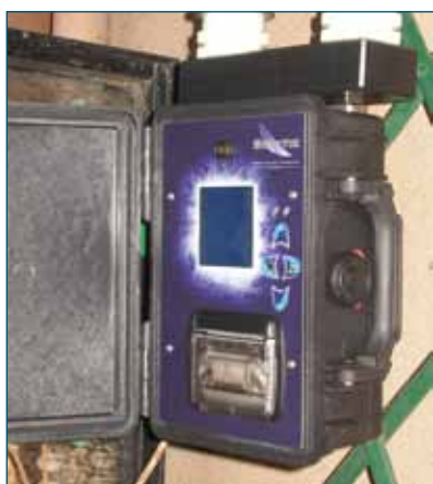
Verifica in pressione con gas di rete
