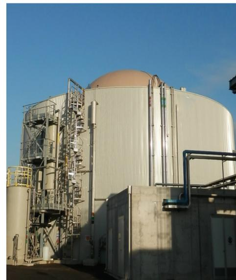
Il biogas è, di solito, ricco di idrogeno solforato dannoso per i cogeneratori e caldaie. Il sistema di desolforazione Fluence si differenzia dalla concorrenza perché non prevede immissioni di aria nella cupola gasometrica né il tradizionale lavaggio del biogas con reagenti chimici.
