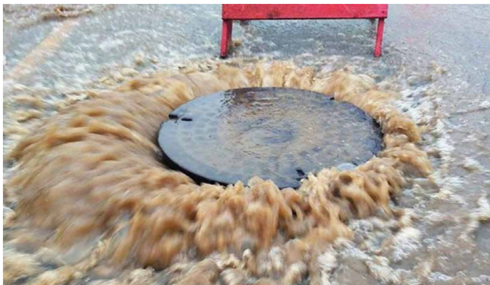
Uno sfioro della fognatura, una vasca di accumulo di acque di drenaggio
